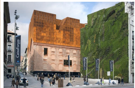
Figure 2.8.34 CaixaForum (Duccio Malagamba, Divisare).132
